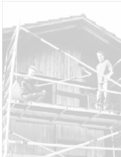
Frisch gestrichen: die Fassade in Wolfenschiessen.
