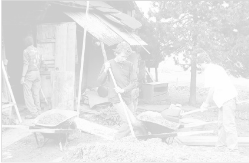
In Wiesenberg wird der Vorplatz des Stalls betoniert.
